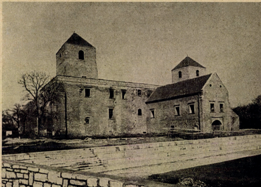
1. ábra. A helyreállítás alatt levő várpalotai vár
