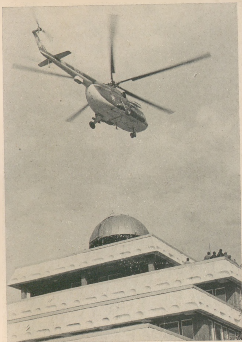
1/b. ábra. A székesfehérvári kupola ráemelése helikopterrel
