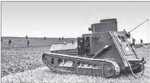
23. ábra. Az Strv m/21-29 menet közben és egy 1935-ös hadgyakorlaton. A képeken jól látszanak a korábbi változathoz képest új, az orr-részen vágott, páncéllal lezárható nyílásba helyezett fényszórók, a fő géppuska új páncélborítása, az új antenna és a módosított kipufogó
