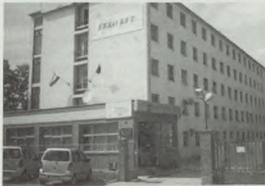
7. ábra: A kollégium épülete
