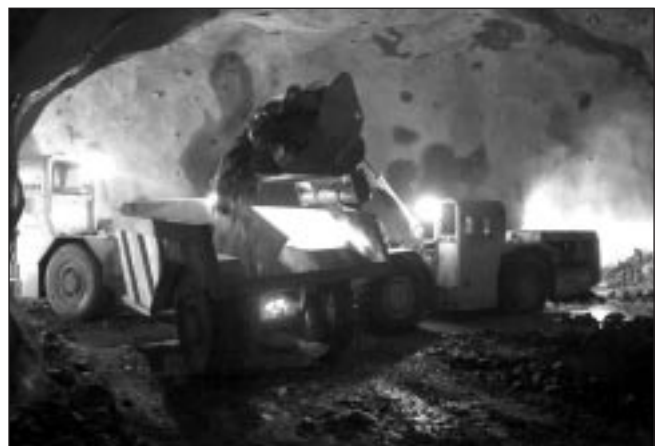
11. ábra: Tárolókamra-építés (a jövesztett kőzet rakodása)
