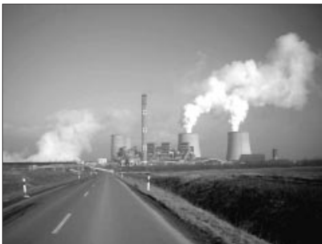
1. kép: Az erőmű távlati képe a kéntelenítőből távozó vízgőzzel (a kéntelenítő a hűtőtorny belsejében van elhelyezve)
