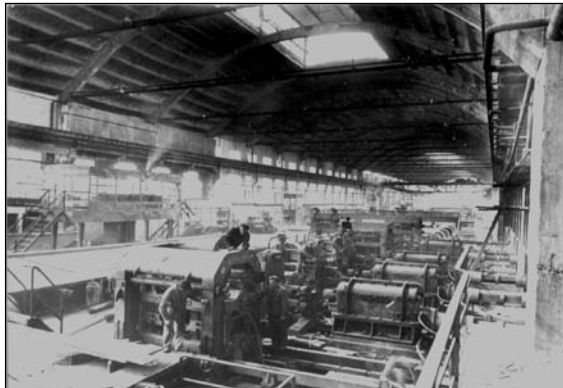
■ 5. ábra. A Középhengermű folytatólagos sori szakaszának szerelése
