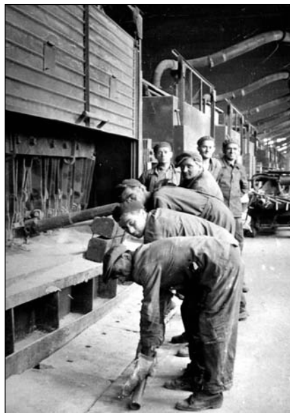
■ 2. kép. Tüskehúzás kézi erővel (1948)
