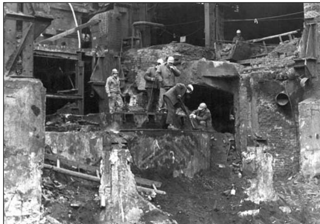
■ 5. ábra. Az I. nagyolvasztó bontási munkálatai
