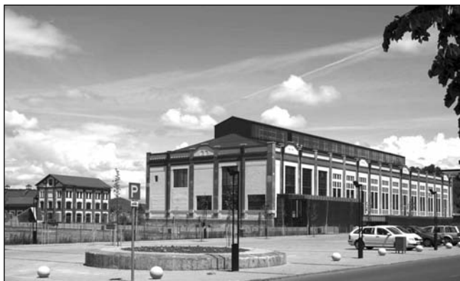
■ A felújított létesítmények: a parkolóban egy acélműi kémény megmaradt alapja, mögötte az egykori erőmű és a fűvógépház épülete
