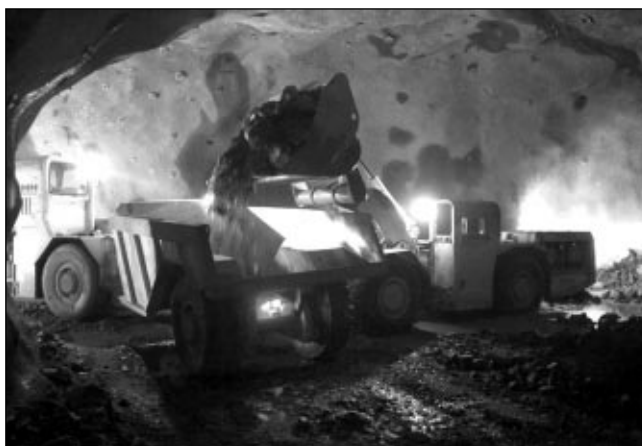
11. ábra: Tárolókamra-építés (a jövészett kőzet rakodása)
