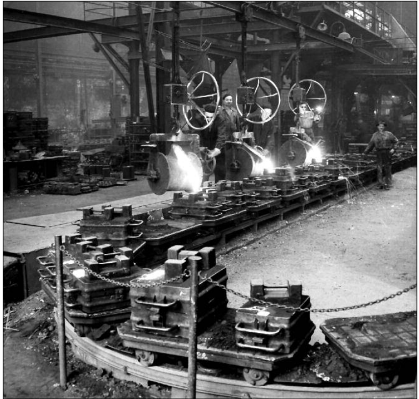
■ 8. ábra. Konvejsorsor a 2. sz. vasöntödében
