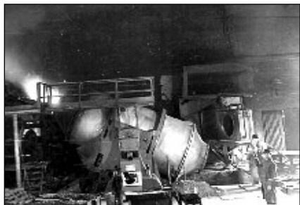
■ 4. ábra. A régi rézfinomító: a Brackelsberg-kemence
