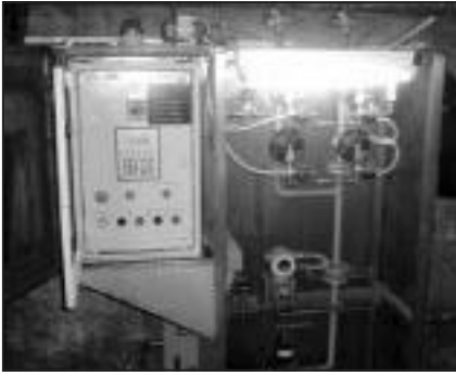
■ 2. ábra. A berendezés gázadagolást vezérlő panele
