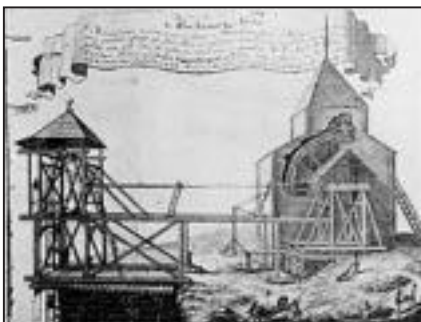
■ 5. ábra. Vízi kerékel hajtott szivattyúrendszer a faluni bányából
