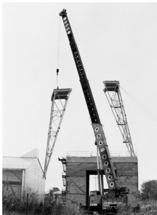
2. kép: A Duplex aknamélyítő csőtorony felszerelése a depressziós ház földemére
