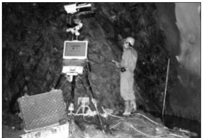
10. ábra: Vágat geotechnikai dokumentálás
