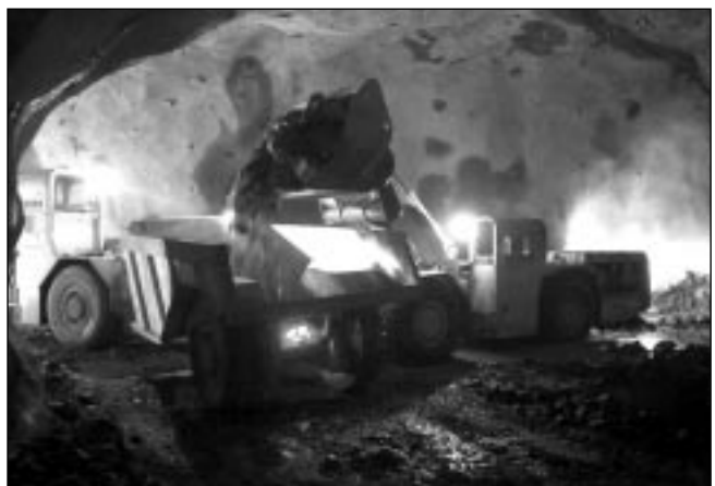
11. ábra: Tárolókamra-építés (a jövészett kőzet rakodása)
