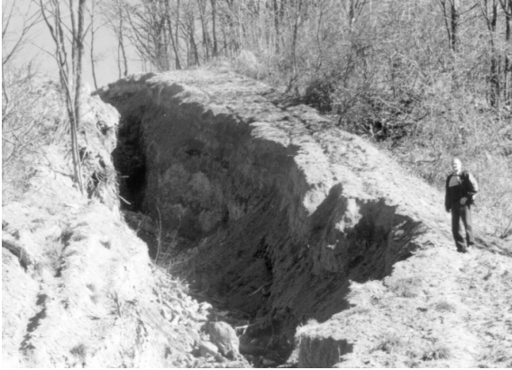
7. ábra Eróziós károk a tájrendezett István I-II aknai meddőhányón
