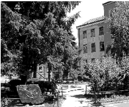
1. kép: A Kő-Szén Kft központi épülete
