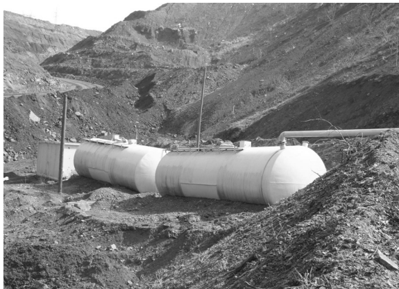
2. kép: A víztározó melletti létesítmények
