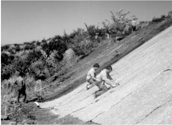
4. ábra Vasas Bánya, üzemudvari meddőhányón eróziómentesítő matrac elhelyezése
