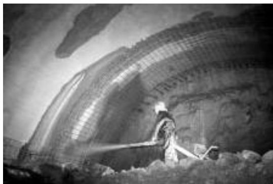
12. ábra: Lövellt beton készítés
