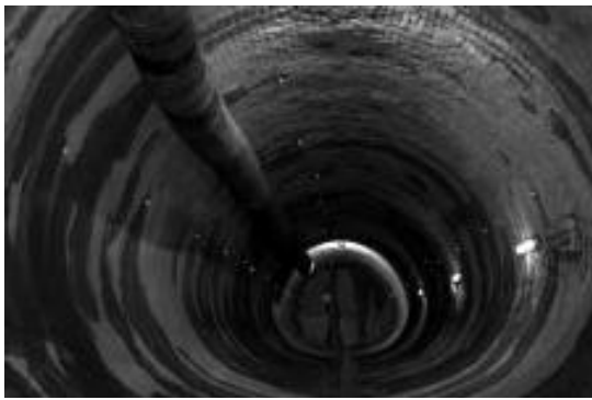
13. ábra: Konvergencia-pontok fénylő prizmákkal
