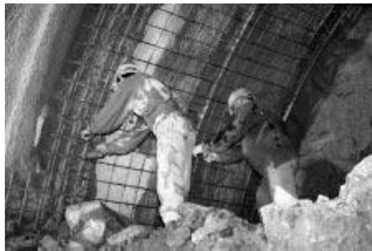
10. ábra: Hálószerelés
