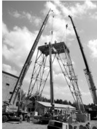
2. kép: Mátraszentimre duplex csőtorony felállítása
