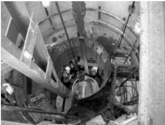
5. kép: Aknabeli munkapad villamos szerelése
