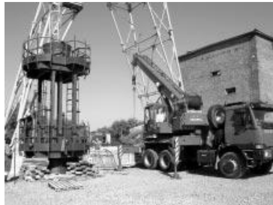
3. kép: Kétszintes munkapad beépítése
