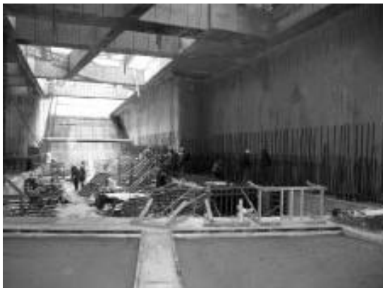
Vasbeton szerelés a Fővám téri állomáson
