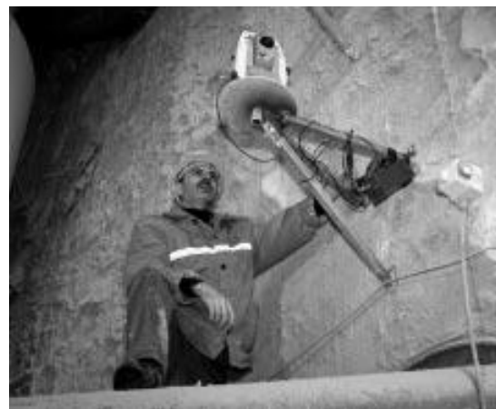
7. ábra: Mérőállomás installálás
