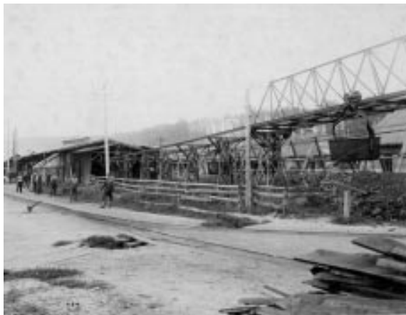
3. kép: Az 1905-ben épült Felsőgalla-újtelepi középállomás
