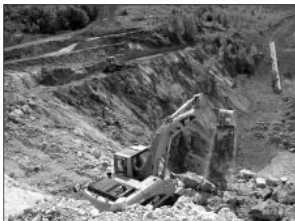
2. képek: Megsuvadt rézsű helyreállítás előtt és után (Nagygyeháza, II. külfejtés)
