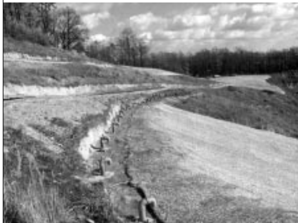
1. képek: A sziklafal lankásítása (Vértessomló, II. külfejtés)
