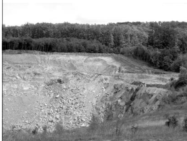
2. képek: Megsuvadt rézsű helyreállítás előtt és után (Nagygyeháza, II. külfejtés)
