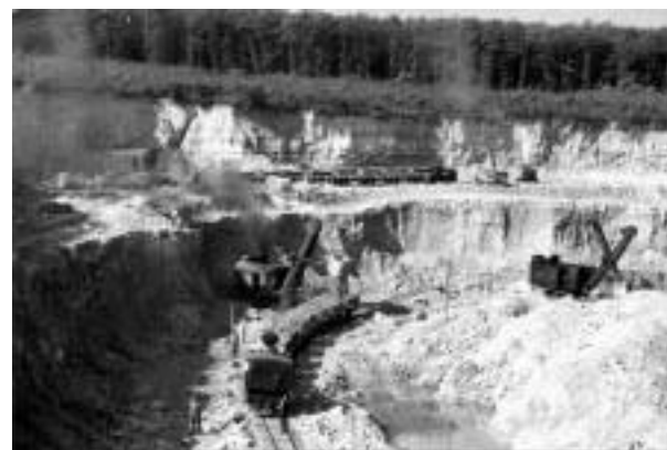
A gépesített rakodás, szállítás
