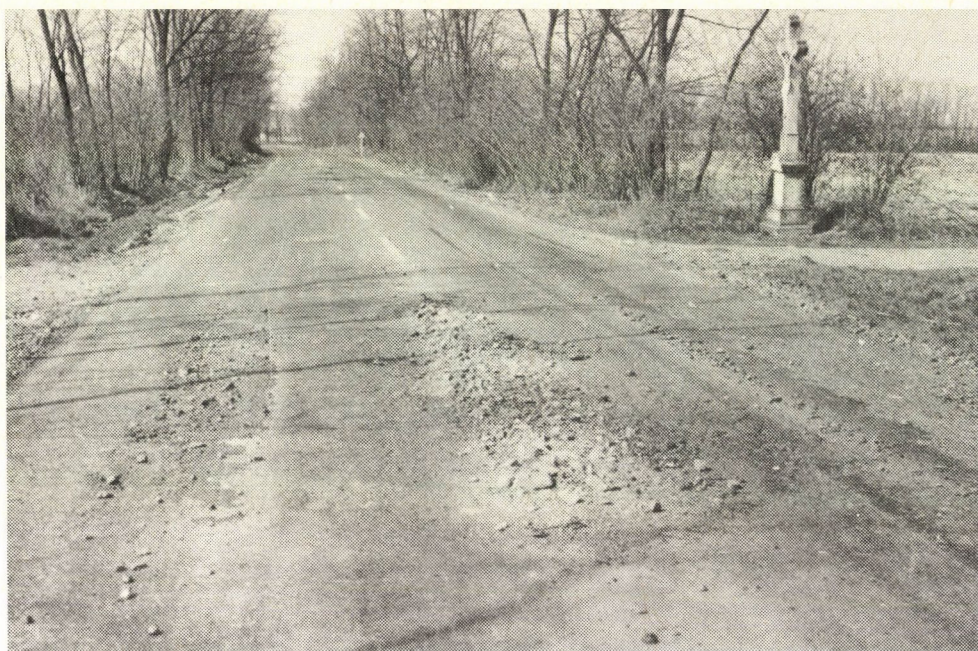
3. kép. A Kisvárda–Tornyospálca út felfagyott része (1981. március)
