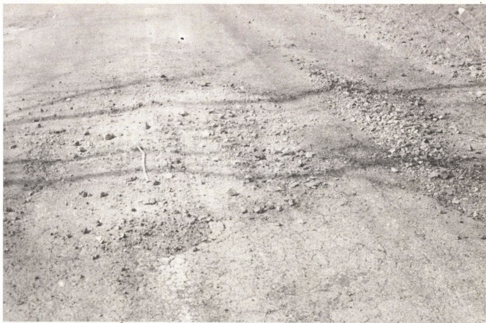
4. kép. Felfagyott útkár Kisvárdától 1 km-re
