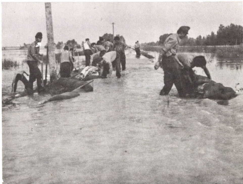
2. kép. A kitört árvíz lokalizálása a Hosszúfoki-főcsatorna jobbparti töltésén (1980. július 28.) Fotó: Kiss Z.
