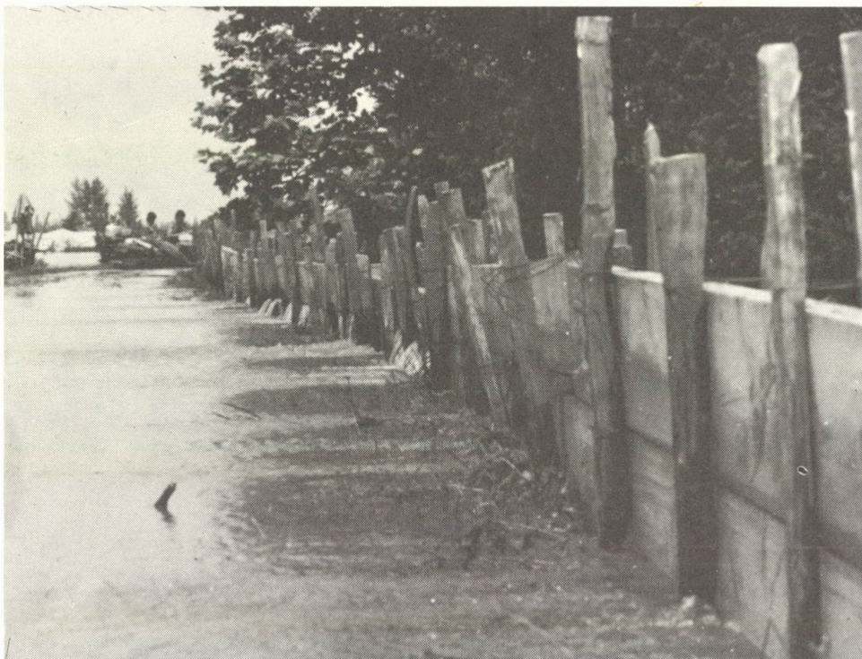
3. kép. Pallósor tartja a vizet a Hosszúfoki-főcsatorna jobbparti töltésén (1980. július 30.). Fotó: Schermann Á.
