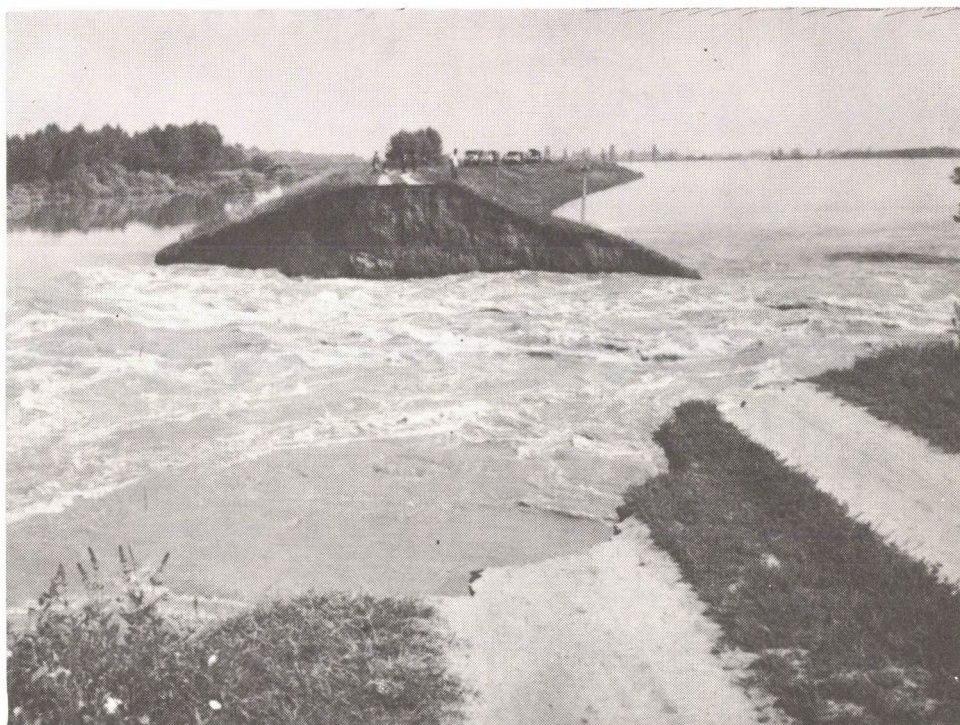
1. kép. A Kettős-Körös jobbparti töltésszakadása néhány órával a szakadás után (1980. július-28.) Fotó: Kiss Z.
