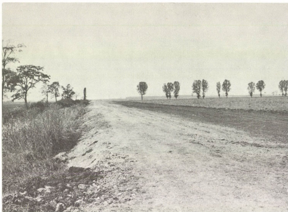
2. kép. A Fekete-ér Sarkad védelmére megerősített töltés
