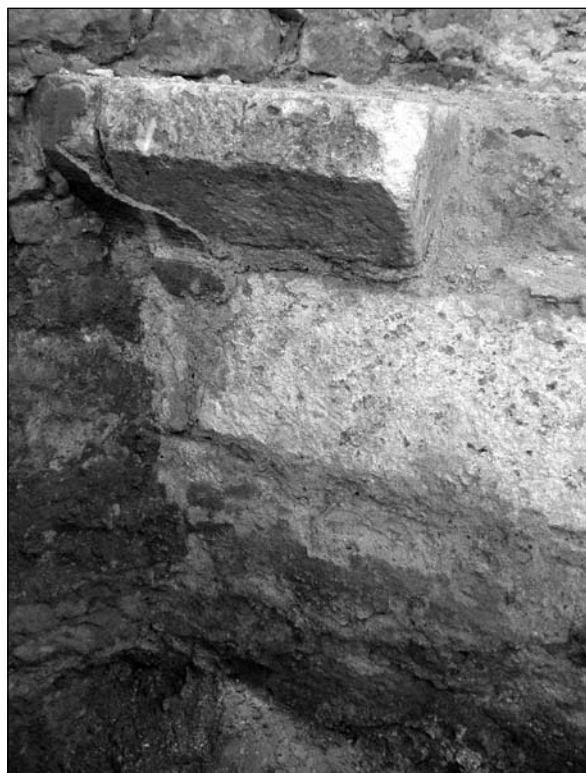
48. kép. Rác fürdő. A forró helyiség kupoláján feltárt in situ török kori párkánykő
