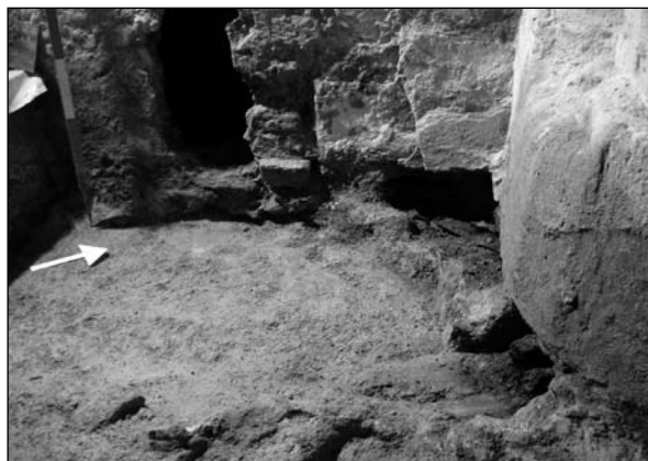
11. kép. Császár fürdő. Forró helyiség. A pillérek alatt feltárt gerendák.
