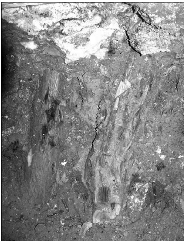
13. kép. Rudas fürdő. A keleti átmeneti helyiség fala alatt feltárt török kori facölöpök.
