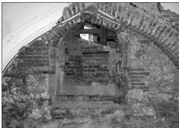
17. kép. Rác fürdő. Forró helyiség északkeleti török ablaka újkori elfalazásokkal.
