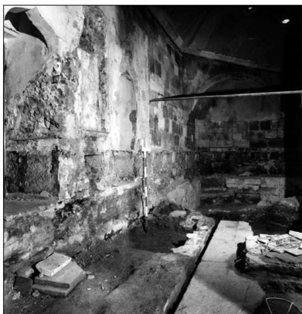
36. kép. Rudas fürdő. Forró helyiségben feltárt török kori padló, a falak mentén húzódó padka alapozásának maradványa és a kettő között húzódó folyóka.
