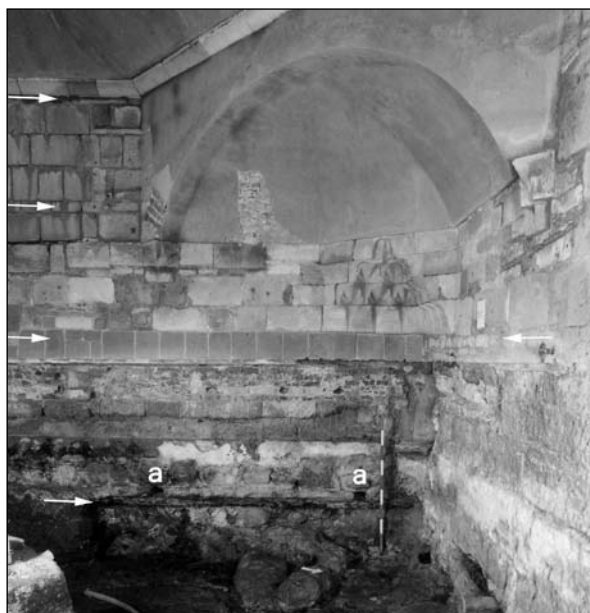
10. kép. Rudas fürdő. Forró helyiség. Nyilakkal jelölve a vízszintes gerendák, „a” betűvel a kereszt elemek.
