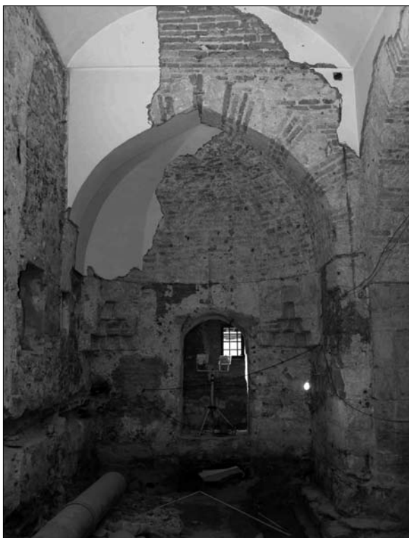
15. kép. Császár fürdő. Forró helyiség, északi dongaboltozatos tér, keleti ívánja, újkori nyílással.
