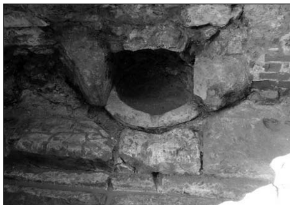
41. kép. Rác fürdő. Az előcsarnok lépcsőjébe épített kút a barokk ráfalazással.
