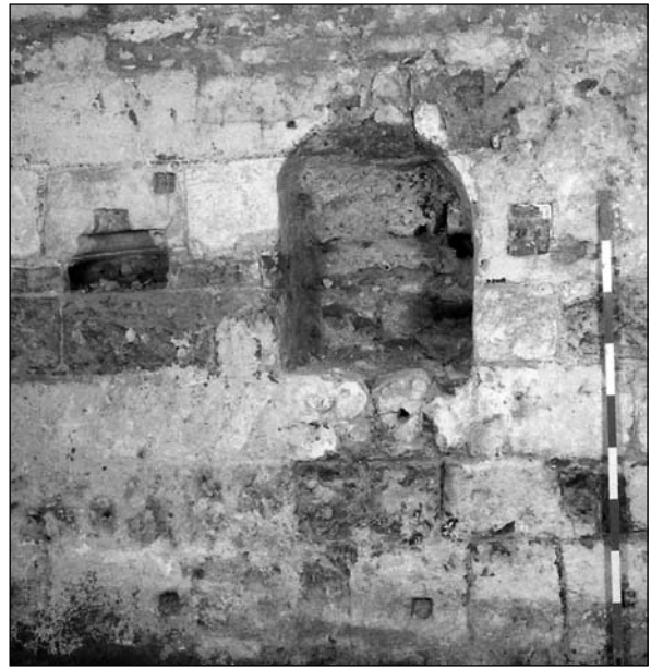
32. kép. Rudas fürdő. Átmeneti helyiség déli falának félköríves záródású második periódusú török kori fülkéje. Balra tőle egy román kori vakívet másodlagos helyzetben.
