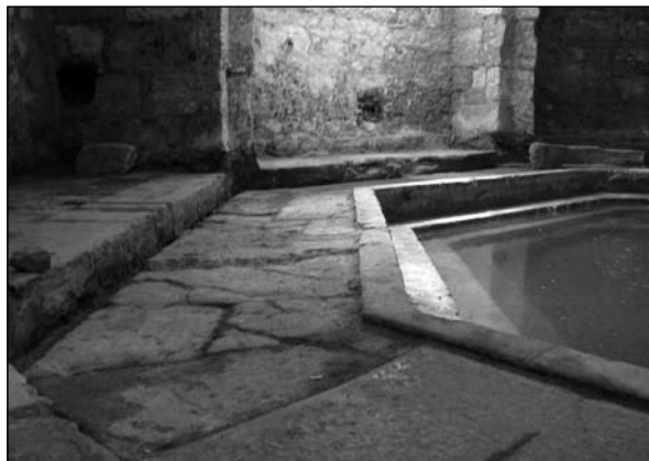
34. kép. Rác fürdő. Forró helyiség. Török kori padló és a falak mentén futó padka.
