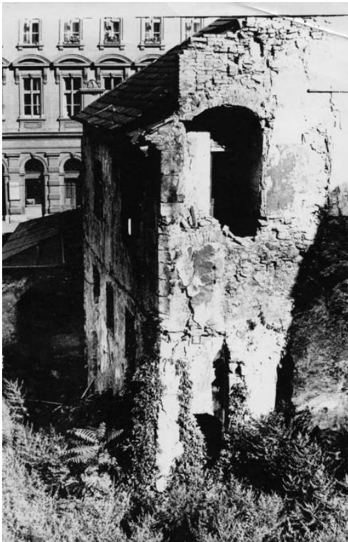
2. kép. A bontás előtt: jól látható az egységes falazás és a kváderes sarokarmírozás
