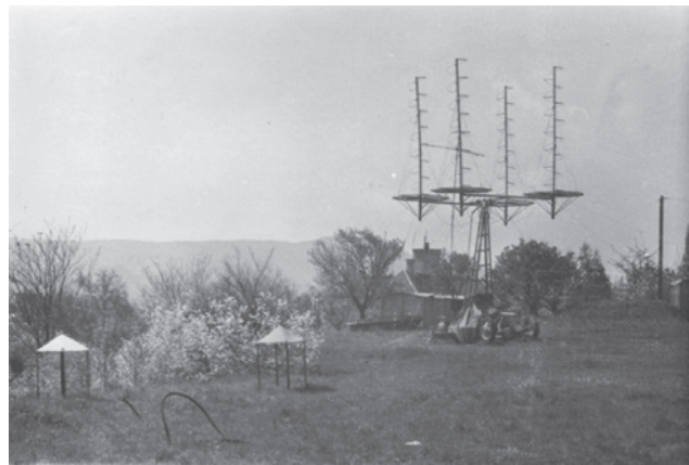
2. ábra. A mérésekhez használt négyes helix antenna mérőállásban a budapesti Ferenc-hegy tetején (forrás: Rádiótechnika 1968/11. sz. „80000 km áthidalása ultrarövid hullámokon”; szerző megjelölése nélkül)
