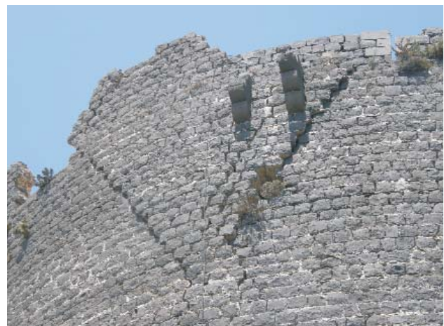
11. kép. Földrengés okozta "V" alakú falkiugrás a donjon déli részén Photo 11. Earth-quake caused "V" form projection of the wall on the southern side of the keep
