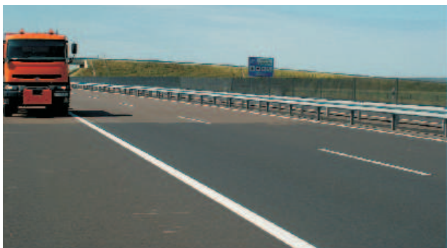
30. fénykép. Az M3-as autópálya 143,5 km-nél. Az útellenőrző kocsik előtt húzódik a recski (szürke, rózsaszín árnyalatú) és a tállyai (szürke) zúzottkőből készült aszfaltburkolat éles határa
