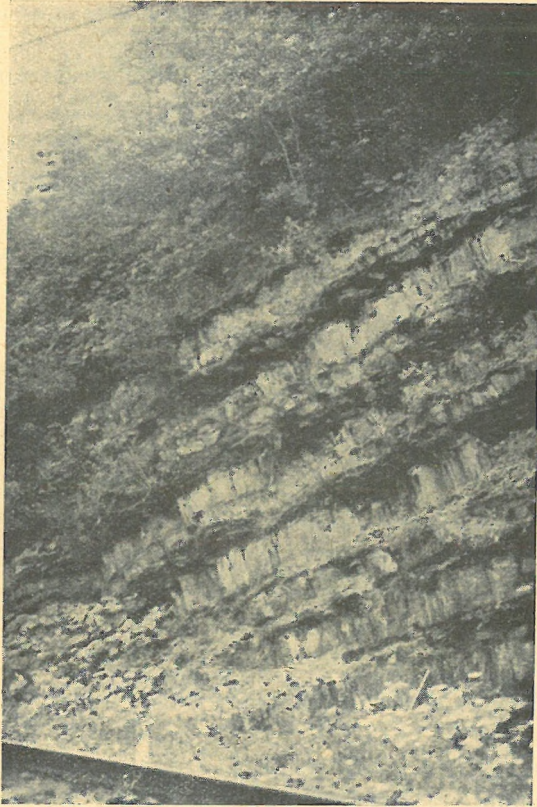
2. ábra. Kréta korú kovás homokkő, pala közbetelepülésekkel. Swidovectől délre a vasúti sínek melletti feltárás. — 2. Figur. Kieseliger Sandstein mit Schiefereinlagerungen der Kreide . Aufschluss südlich von Swidovec, neben der Eisenbahnlinie.
