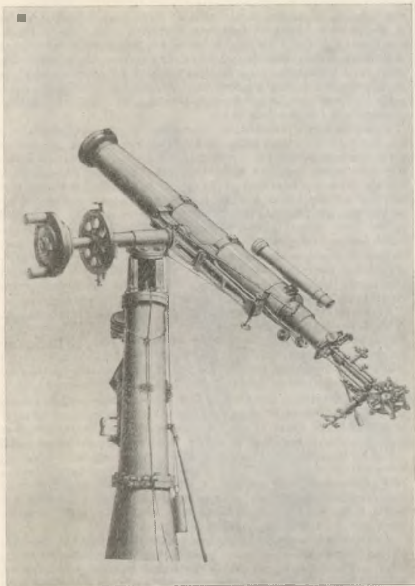
5. ábra. A kalocsai Haynald-obszervatórium 7 hüvelykes Merz-refraktora a Hilger-jéle protuberancia-spektroszkóppal
