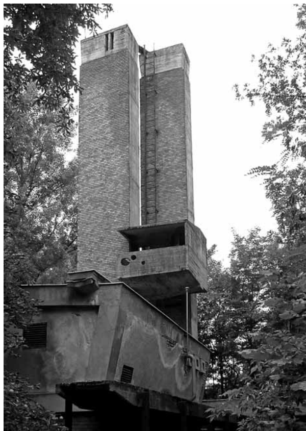
8. Üdülő kazánházának kéménye, Balatonszemes, Ady Endre utca Fotó: Ferkai András
