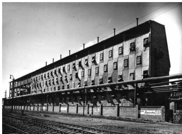
3. Szabó István–Baka Endre–Márton Botond: A Zagyvapálfalvai Üveggyár generátorháza előregyártott homlokzati panelszerkezettel, 1958–1959 (Modern) (Ipari) Építészetért Alapítvány – IPARTERV Fotóarchívum, No. 5341
