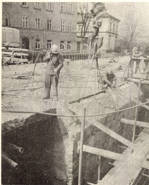
4. kép: A vasbeton szerkezeti darabok porlándzsás szétvágása
