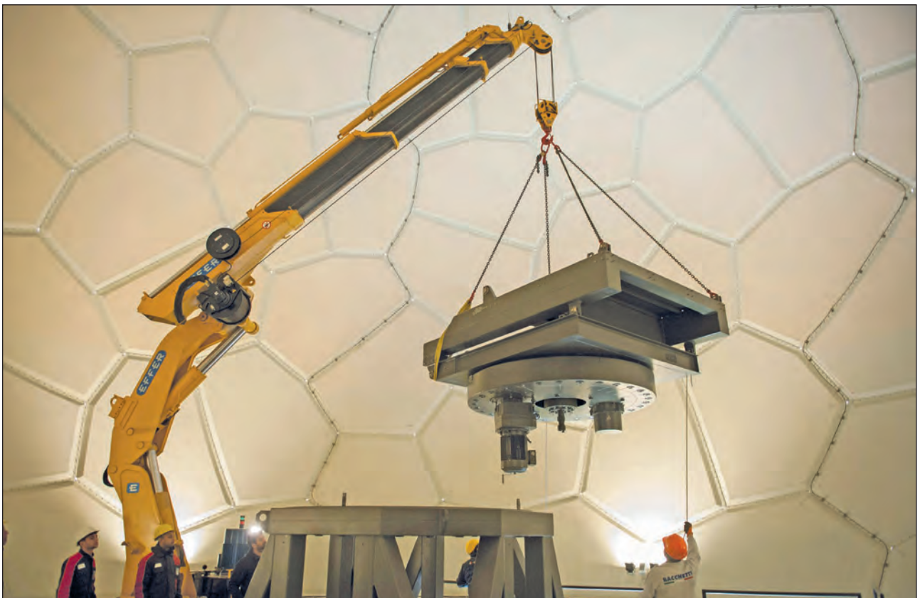
4. ábra. A radar beépítése a radomba
