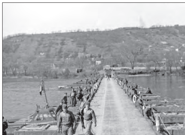
12. ábra. Az elkészült híd Leányfalu alatt a Szentendrei Duna-ágban, 1961. március 17-én. Bal oldalon az AVM-ek készenlétben állnak, szükség esetén „támasztják” a híd
