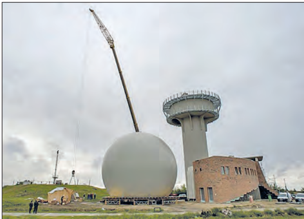
2. ábra. A radom még a földön, beemelés előtt
