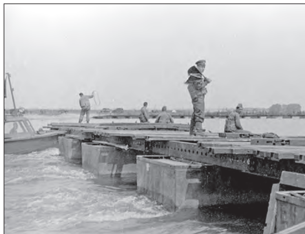
13. ábra. 1961. szeptember 13. A 16 tonnás hídtag toló-úsztatása a hídvonalba. Az úsztatást két AVM végzi
