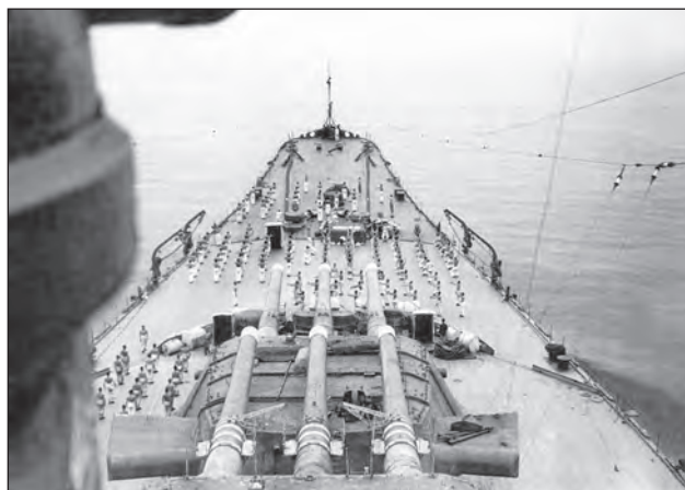
15. ábra. A MUSASHI orra a felépítményről fényképezve. A fotón jól látható a 6 db előre néző 460 mm-es löveg (Fotó: B.B.)
