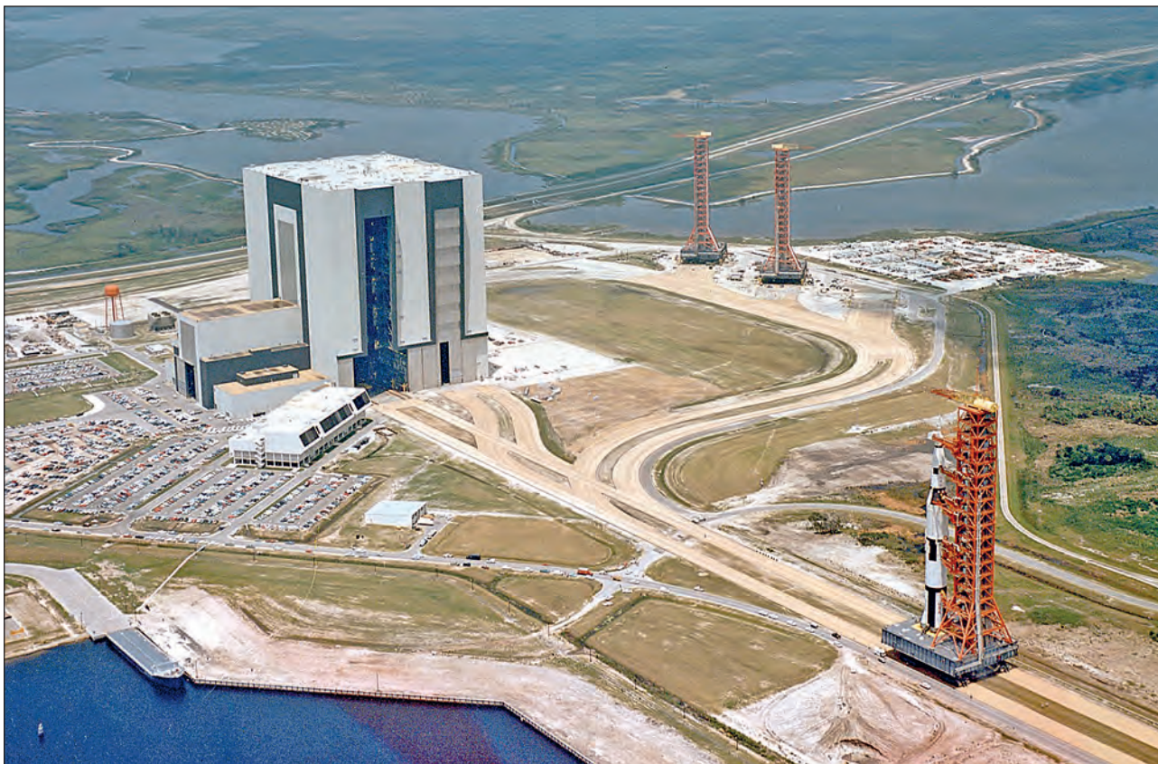
15. ábra. Az eredetileg megépített 3 MLP három indítóhelyre vihette volna ki a szerelvényeket. Végül csak a 39/A és a 39/B épült meg, a 39/C nem. 1981 óta innen indították az űrrepülőgépeket is (NASA)
