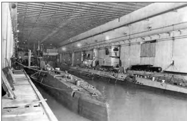
8. ábra. A légveszély miatt a németek tengeralattjáró-bunkereket (például Keroman I. és II.) építettek, hogy a javításokat, karbantartásokat védett helyen végezhesék. Ezeket a bunkereket a szövetségesek 5400 kg-os Tallboy bombái sem tudták megsemmisíteni
