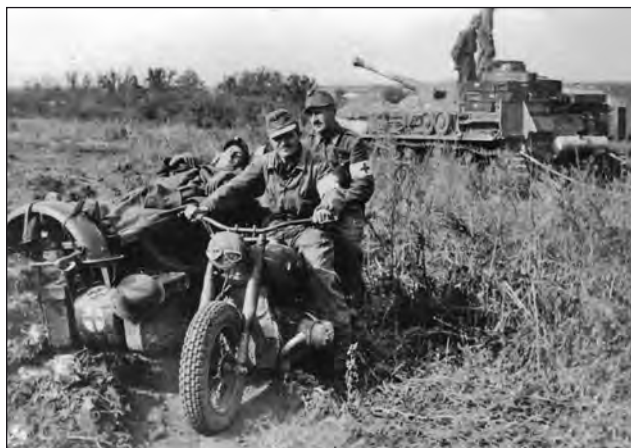
29. ábra. Sebesültszállításra átalakított BMW R 75-ös. Az első sárvédő leszerelve az oldalkocsi orrán (Fotó: Somorjai)
