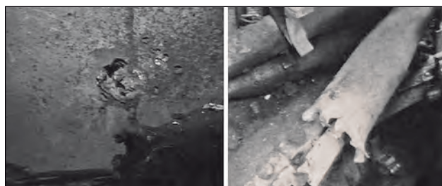
25. ábra. A Maljutka rakéta kimeneti nyílása a torony hátsó páncélján és a megromgált gránátok
