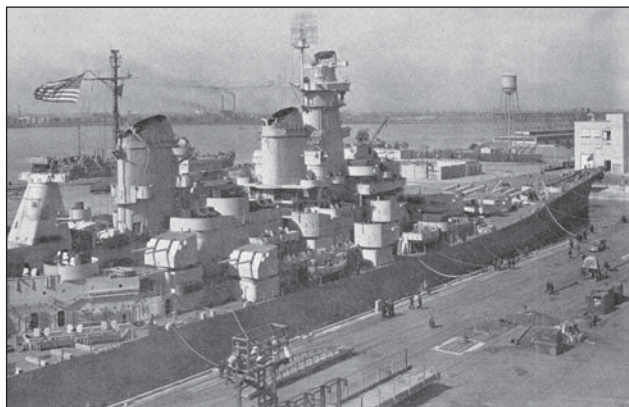
14. ábra. Az IOWA 1943. március 28-án a hajógyárban, felszerelés alatt. A legmagasabb részegység az SK légtérfelderítő radar, előtte, valamivel alacsonyabban a fő távmérő
