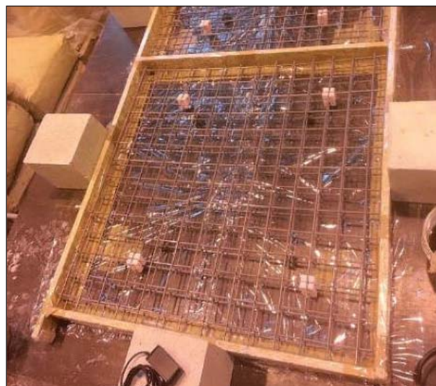
3. ábra. A lemezekben elhelyezett betonacélháló
