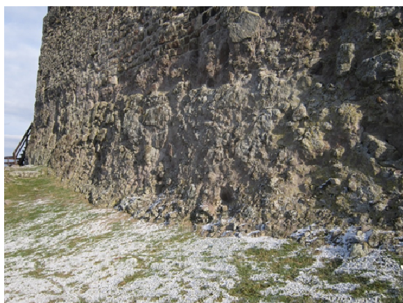
3. ábra. A visegrádi Fellegvár (KEF 8279.2) nyugati falának andezit lábazata
