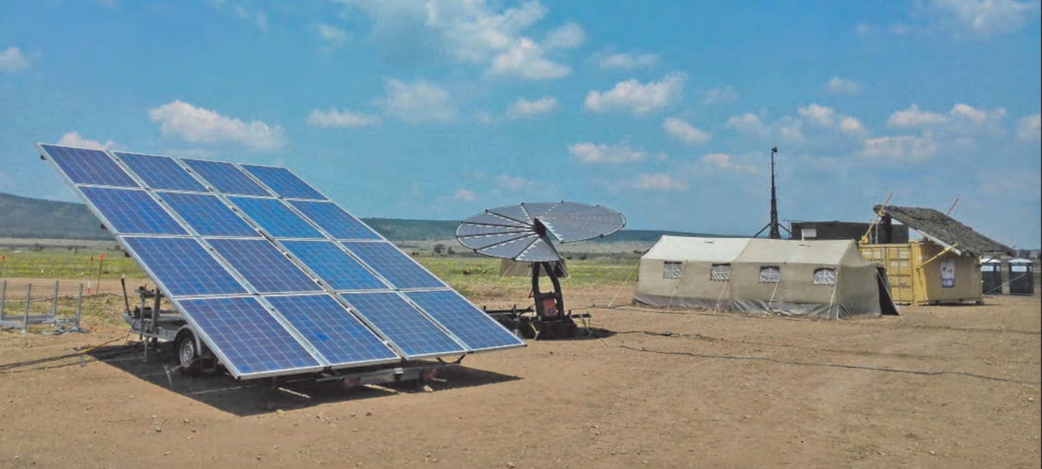
6. ábra. A konvencionálisabb egyszerű és a futurisztikus szolár-megoldások tökéletesen kiegészítették egymást. A háttérben látható harmadik panel nem napelem, hanem napkollektor
