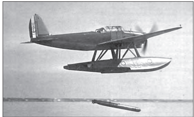
34. ábra. A francia haditengerészet 880 LE-s, soros motorral szerelt Latécoère 298-as torpedóvető-zuhanóbombázó hidroplánjából 81 db-ot gyártottak. Ilyen, maximálisan 330 km/h sebességre képes repülőgépek szolgálták a COMMANDANT TESTE hidroplán-anyahajón (S.Gy.)
