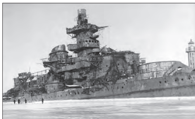
9. ábra. A GNEISENAU roncsa a gdanski kikötő bejáratánál, 1946 telén. A fegyverzetet partvédelmi célra távolították el. A torony tetején a távmérő hengeres házán látható hosszirányú keretek a lokátor rögzítésére szolgáltak (H.Z.)
