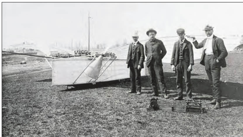
11. ábra. Az „Nr 21” repülőgép két légcsavarral és két motorral rendelkezett, ezek egyike látható Weißkopf és társainak lábai előtt. A motorok összegzett teljesítménye 30 LE volt
