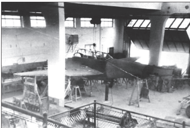
3. ábra. Az X/H gázturbinás harci repülőgép sárkányszerkezete a ferihegyi hangárban
