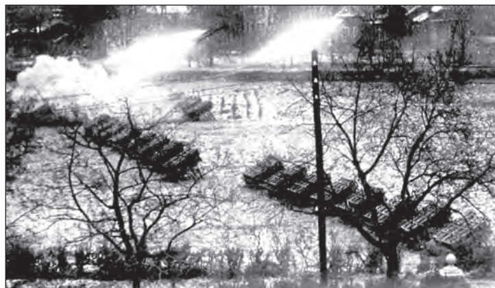
27. ábra. A Wurfgerät 40 egy egyszerű, földre helyezhető fa/acél állványzat volt a 28/32-es rakéták indításához. Ez a rakétacsomag félláncfalas fegyverhordozón Wurfrahmen 40 néven volt ismert
