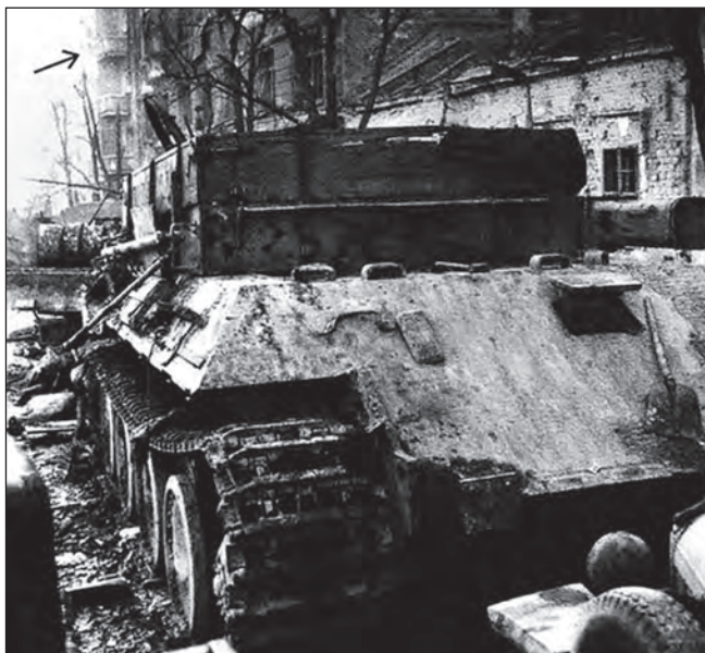
15–16. ábra. A Panther harckocsi átépítésével kialakított műszaki-mentő Bergepanther az Attila úton
