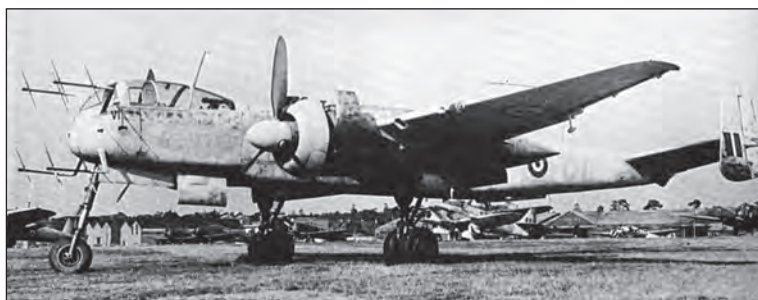
4. ábra. He 219-es Uhu éjszakai vadászipülőgép lokátor-antennákkal a fülke orr-résznél. A fedélzeti lokátor hatósugara 4-6 km volt. A képen látható repülőgép angol zsákmányanyag
