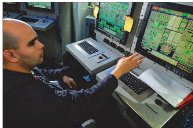
29. ábra. A korszerűsítések eredményeként a korábbi analóg skálás műszereket felváltották az érintőképernyős terminálok
