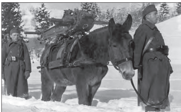
4. ábra. 15M 7,5 cm-es hegyiágyú elülső lövegtalpa öszvérre málházva
