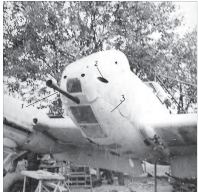
9. ábra. A 40 mm-es Bofors gépágyú beépítése az orrban előlről a kísérleti Me 210-esen. Jelmagyarázat: 1. 40 mm-es gépágyú; 2. a bal oldali 20 mm-es gépágyú; 3. átalakított lövésztekő a közelfelderítő változathoz (S.Gy.)
