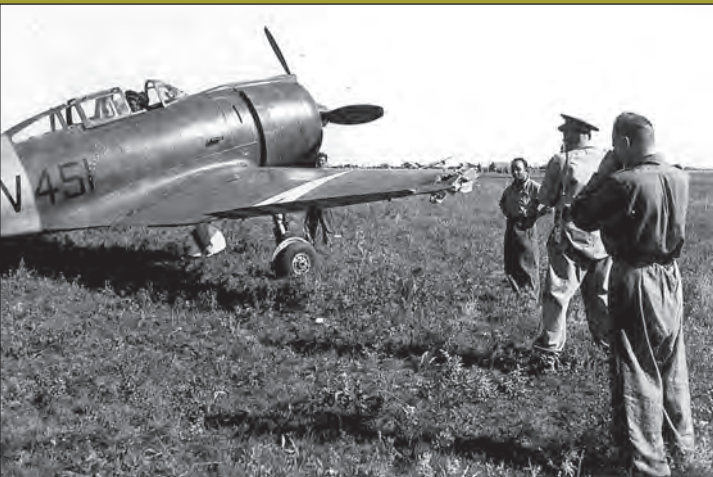
5. ábra. A sebesült Pittenbacher által visszahozott, „baráti tűz” áldozataként esett, sérült V.451-es gép. A szárnytőnél a mindegyik Héjára felszerelhető fotógéppuska 4 db felerősítő bakja látszik. A gép oldalán a fekete Venturi csövön látható egy előremutató fehér nyíl, amelyik a felszerelési irányt mutatja
