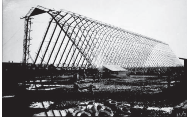
14. ábra. Helyére emelik az utolsó tartót. Erre rögzítik majd az eltolható ajtókat
