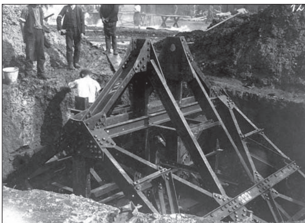
11. ábra. Ezeken a rögzítő idomokon fordul el a tetőszerkezeti elem, amikor felállítják (1915. X. 1.)
