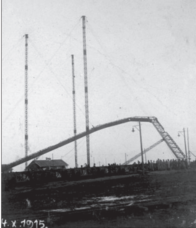
10. ábra. Felállítják a csarnok első elemét (1915. X. 14.)
