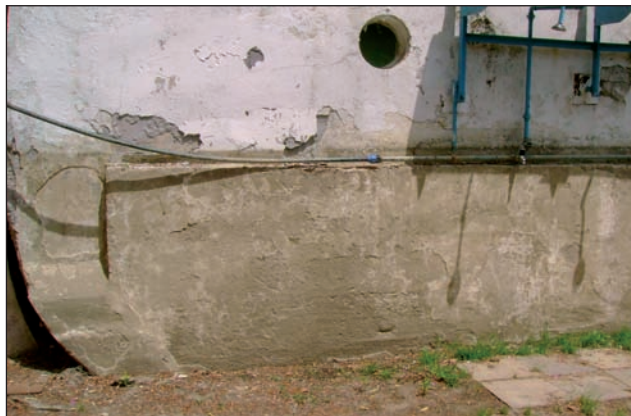
10. ábra. A hajó tört része betonnal befalazva
