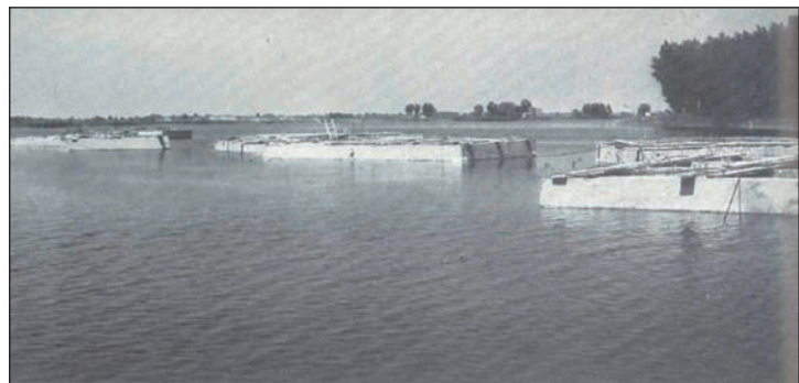
6. ábra. Betonhajó részegységek
