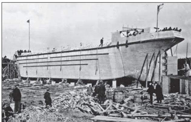
7. ábra. Betonhajó építése
