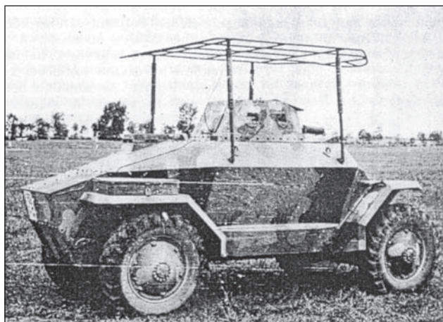
34. ábra. 40 M. Csaba parancsnoki páncélgépkocsi tetőantennával
