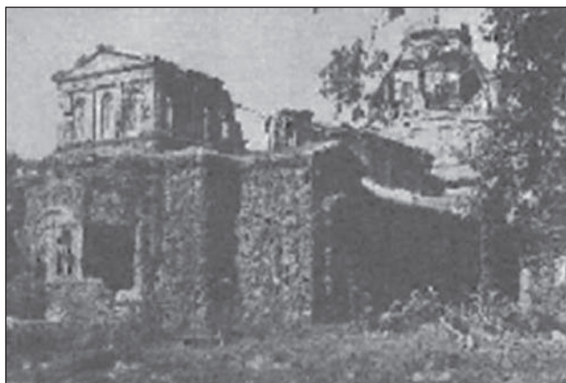
61. ábra. A sziget épületei romokban
