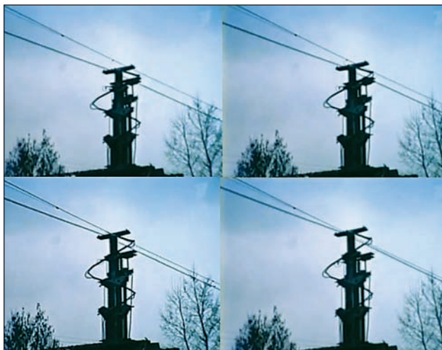
16. ábra. A vezetékesfeszítő szerkezet működésének első fázisa
